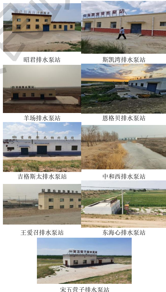
图 0-4 达拉特旗沿黄排水泵站
