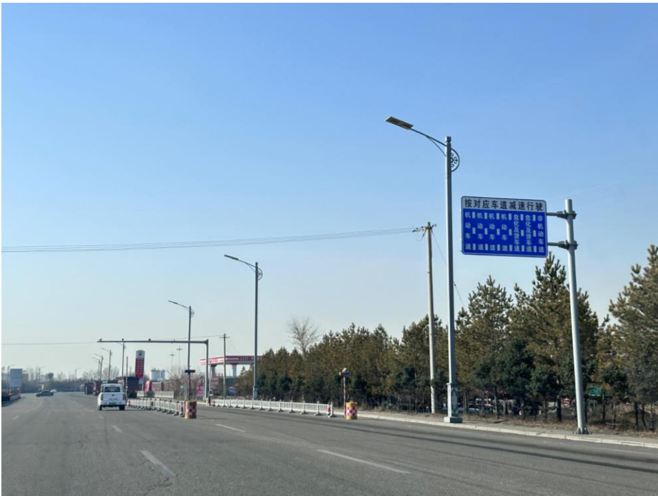
图 2.4-5 园区纬七路与经七路交叉口东侧卡口道闸
